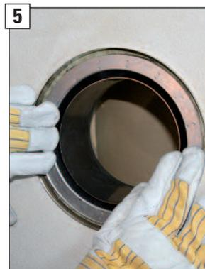
**5** Anschlagring des Anschlussfutters muss dicht am Schamottestützen angepresst sein.
