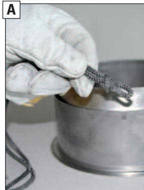
Keramikdichtband mittig zusammenlegen und einen Knoten binden.
