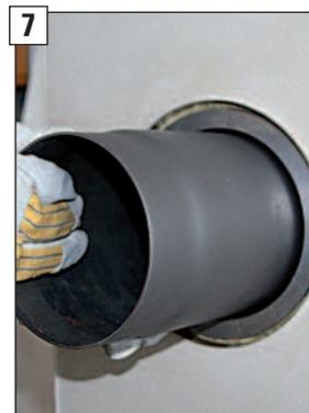
**7** Die bauseitige Verbindungsleitung zum Ofen kann jetzt in das Anschlussfutter eingesteckt werden.
