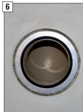
**6** Fertigansicht des eingebauten Anschlussfutters mit Keramikdichtband.
