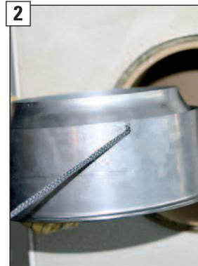
**2** Das Knotenende des Keramikdichtbandes in den Knotenfänger des Anschlussfutters einhängen.
