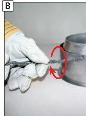
Das Knotenende in den Knotenfänger einhängen und das Keramikdichtband verdrillen.
