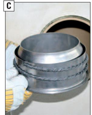
Das verdrillte Keramikdichtband spiralförmig und straff um das Anschlussfutter wickeln.
