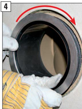
**4** Anschlussfutter mit aufgewickeltem Keramikdichtband in das Schamotteanschlussformstück in Wickelrichtung hineindrehen.
