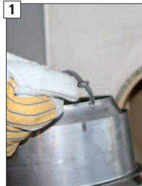
**1** An einem Ende des Keramikdichtbandes einen Knoten binden.
