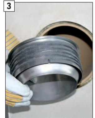
Keramikdichtband spiralförmig und straff um das Anschlussfutter wickeln.
